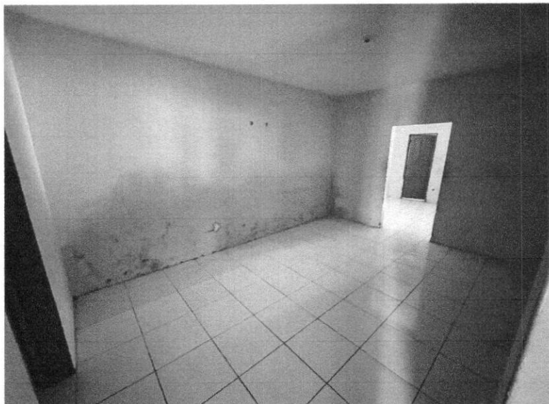
Imagem 04: Parte interna do imóvel – Sala 02
