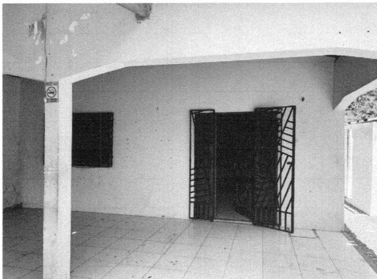
Imagem 02: Fachada frontal do imóvel
